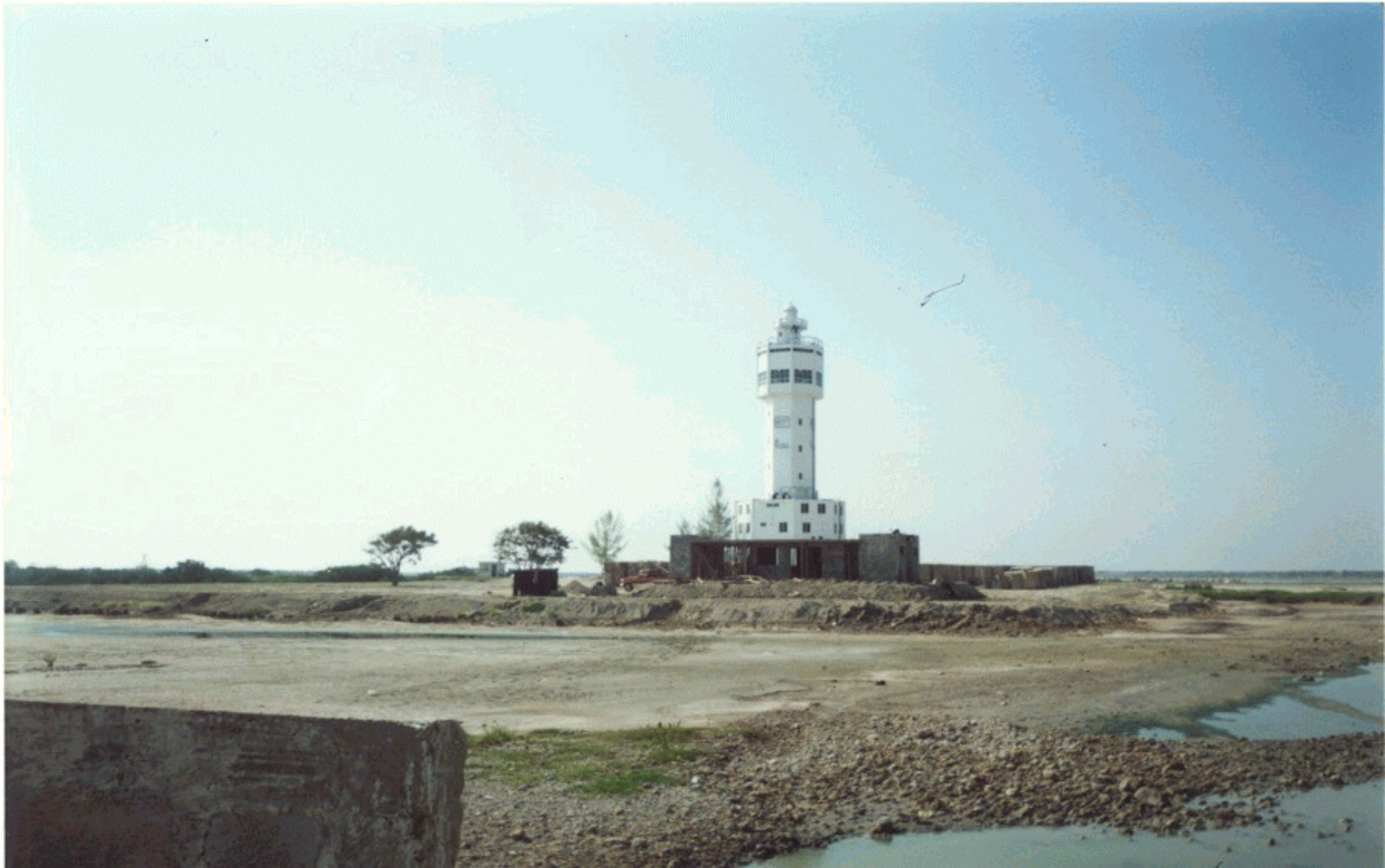
LTAMIRA CONSTRUCTION SITE
