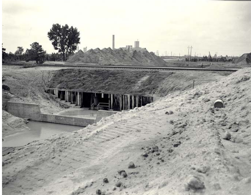
Figure 6 Effluent Stream, P-Area Construction of P Area Canal to Par Pond (further downstream from P Area, heading toward Par Pond) (DPSPF-6872-36) 8/17/1960
