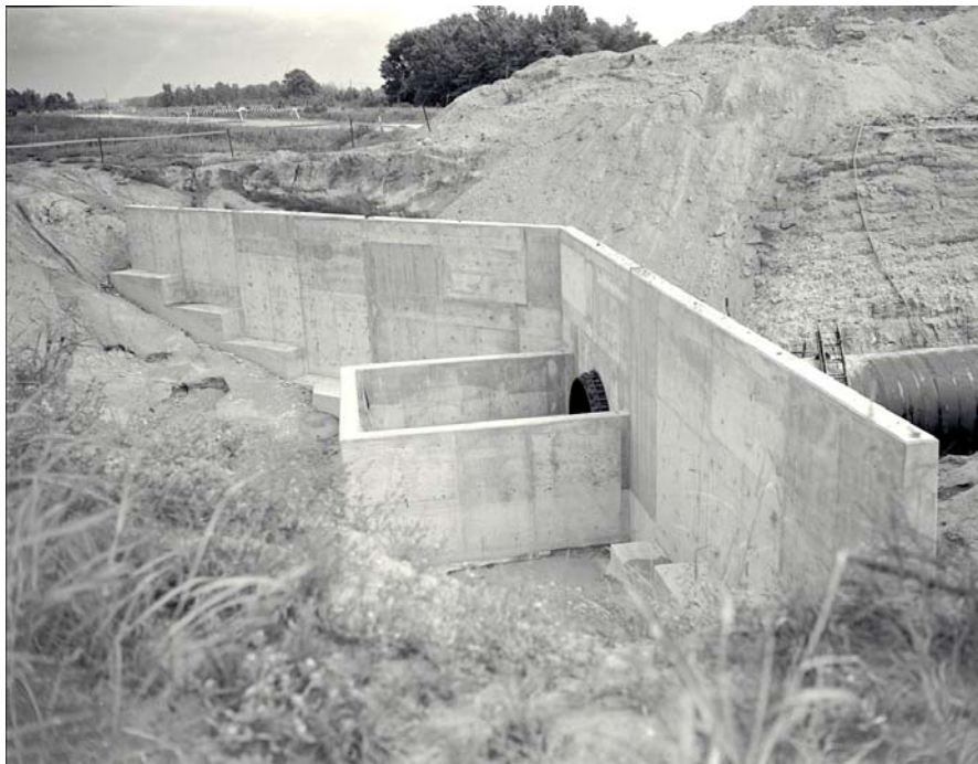
Figure 5 Effluent Stream, P Area Construction of Discharge Point to Par Pond (DPSPF-6872-47) 8/17/1960
