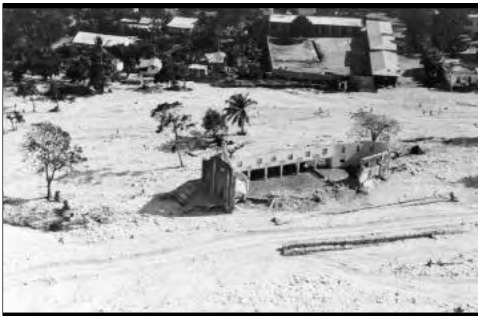
Fonds Verrettes. Villa destruida.
