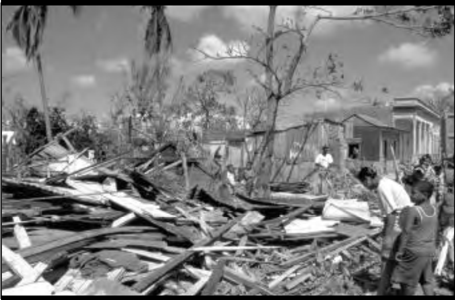
En las áreas más afectadas por los vientos se observó una destrucción completa de las viviendas marginales.
