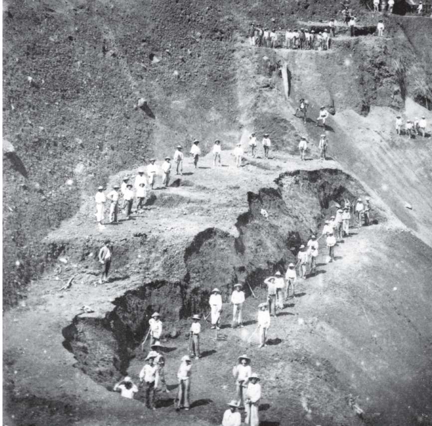
Construcción ferrocarril, Chimbo, 1890
