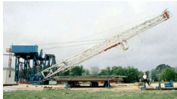
Fig. 1. Hoisting the mast
