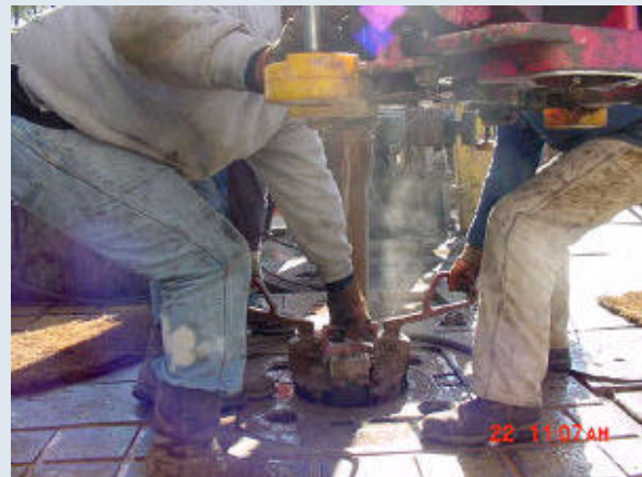
Fig. 14. Pulling slips
