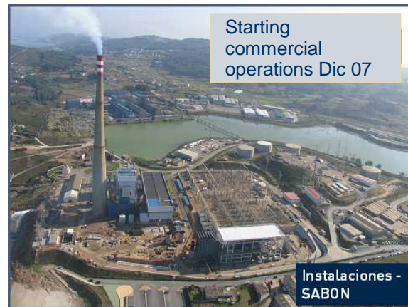
CCGT SABON - 400 MW
