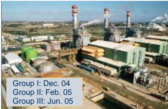
CCGT Palos - 1.200 MW
