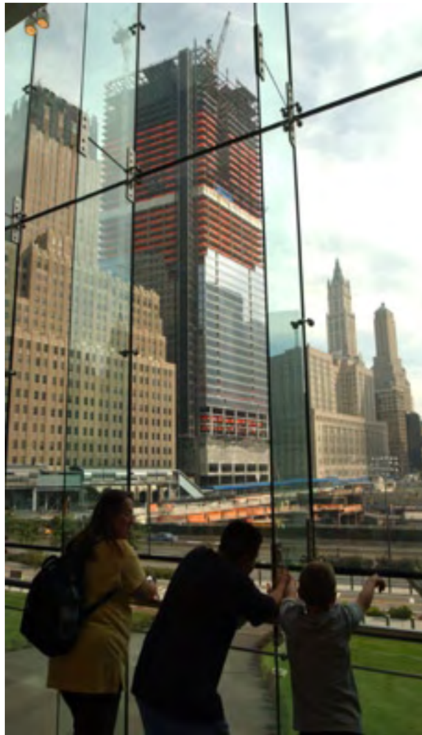
Progression des travaux au Seven World Trade Center, détruit lors des attentats du 11 septembre 2001.
