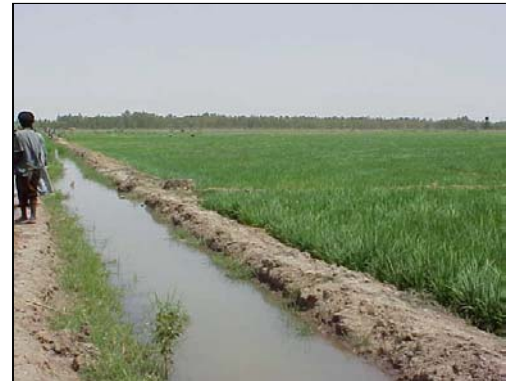
Un canal non revêtu en béton permet la déperdition de l'eau.
