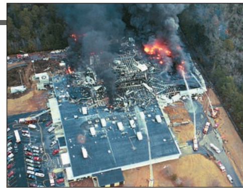
La fábrica de goma Farmacéuticos West en Kinston, Carolina del Norte, después de explosiones de polvo.
