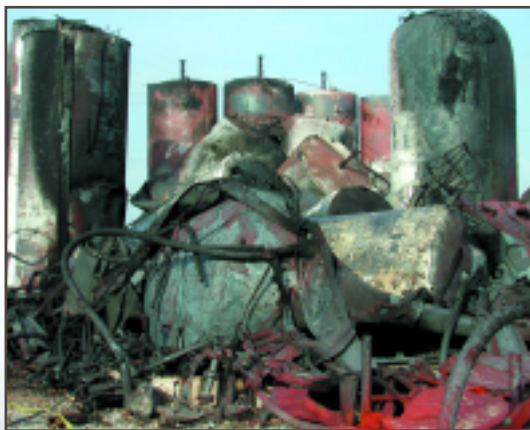
Los tanques de almacenamiento en Third Coast colapsaron por el intenso incendio que ardió por más de 24 horas.
