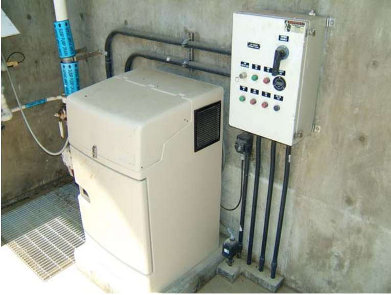
Effluent Sampler
