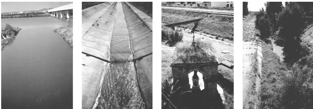
Figura 8. Estado actual del Tagarete -Canal del Tamarguillo-.
