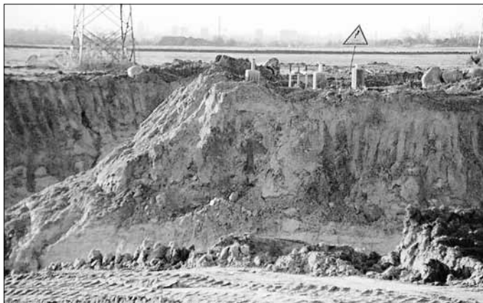
Massenweise wird Erde abgetragen 31.10.2001
