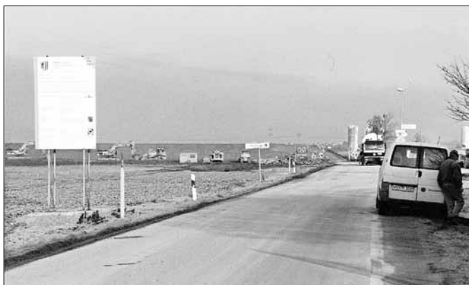
... und wieder bis ca. 5 m Höhe eingebracht 14.11.2001
