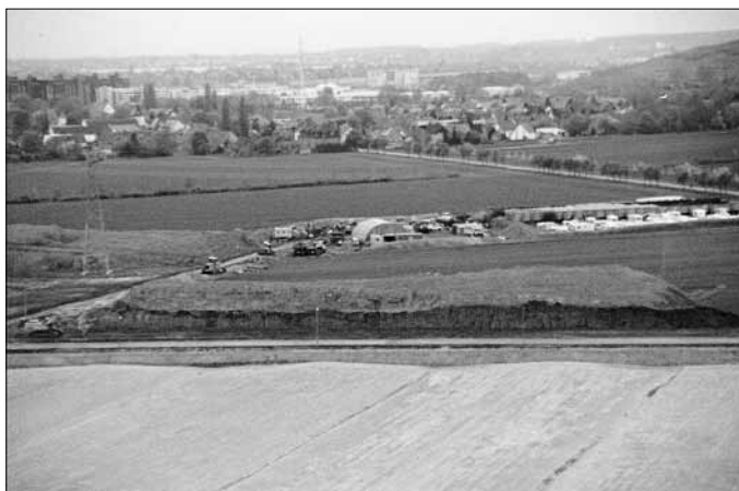
Bis Ende April war der Industriepark eingeebnet
