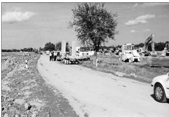
Baugeräte rollen an 08.10.2001
