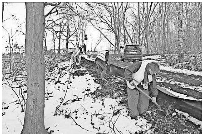
Aufbau des Krötenzauns an der Parthebrücke. Foto: René Sievert
