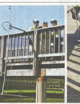
アーム型カメラで桁下を見る
