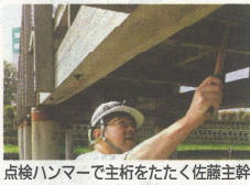
点検ハンマーで主桁をたたく佐藤主幹
