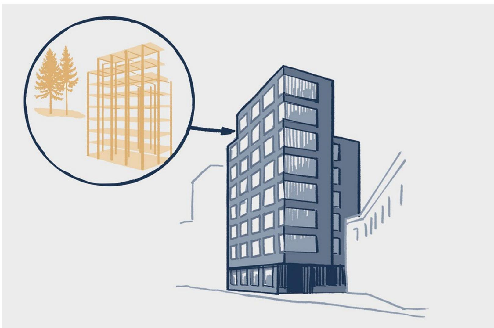
Ein Beispiel für ein vorbildliches Gebäude der kantonalen Verwaltung ist der Bürobau für das Amt für Umwelt und Energie, hier an der Spiegelgasse 15. Die Stützkonstruktion des Gebäudes besteht aus regionalem Fichtenholz, einem erneuerbaren Rohstoff.
