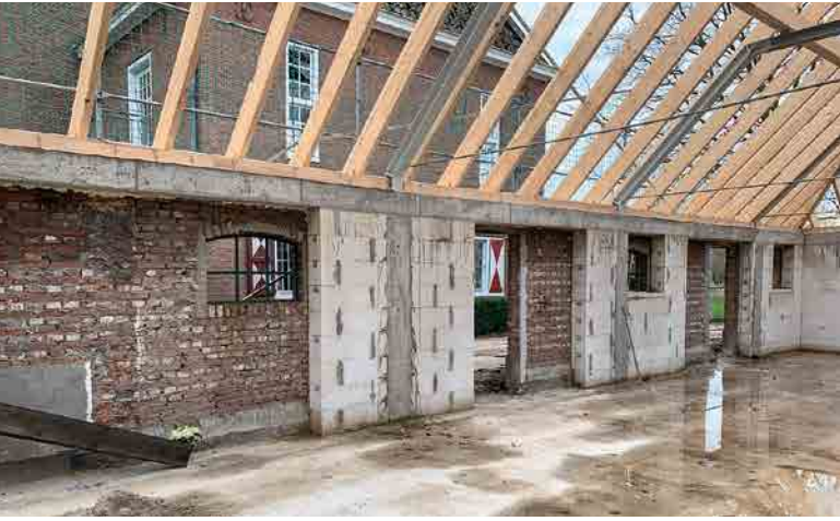
Hinter den Ziegeln des Pferdestalls entstand ein völlig neuer Raum. Durch das noch ungedeckte Dach sieht man das Schloßchen.
