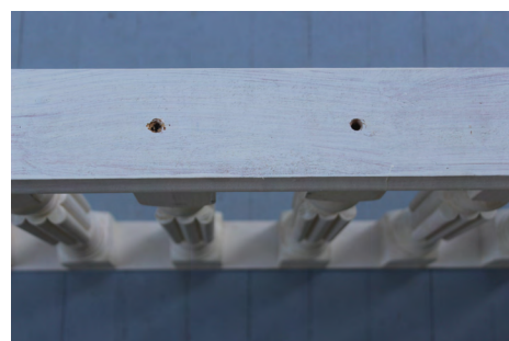
5. Vissage à l'envers de la lisse inférieure à la base des balustres (vis non apparentes).
