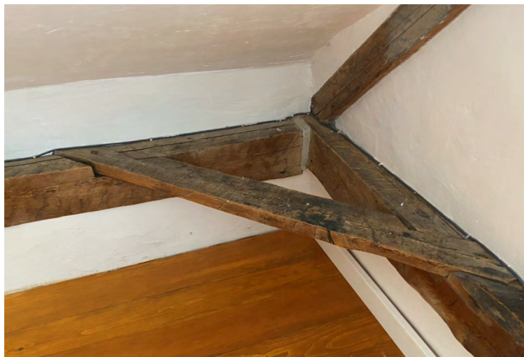
4. Gousset de 4 pieds et 10 pouces pour solidifier la sablière dans les coins.
