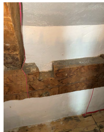
5. Encoche de la traverse centrale.
