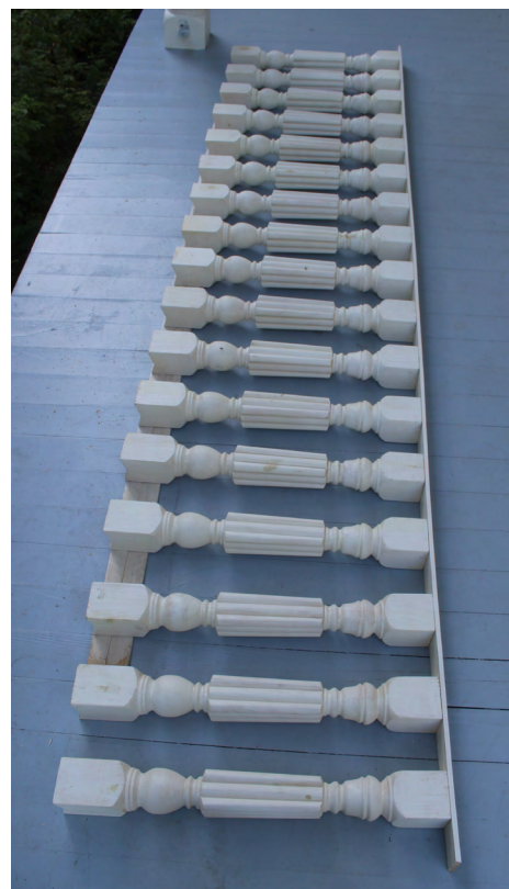
4. Technique d'assemblage des balustres à plat et visés dans une latte de bois par le dessus.
