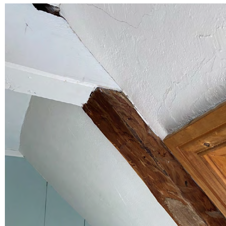
2. Nouvel entrant cloué au chevron d'origine.
