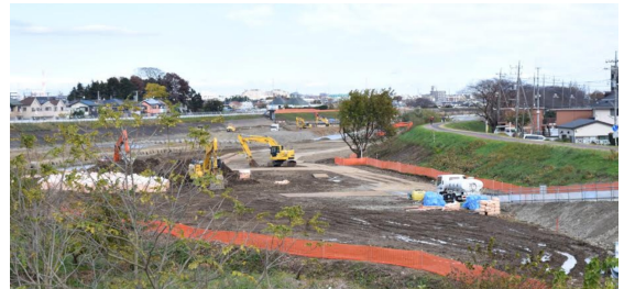
一番橋下流工事
