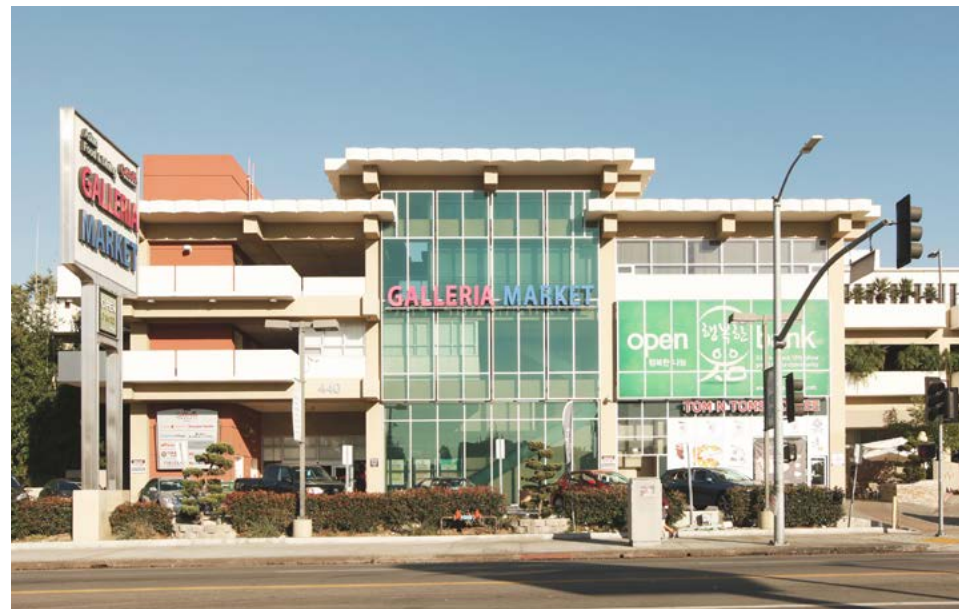
Vermont Galleria, 440 S Vermont Ave, Los Angeles CA 90020
