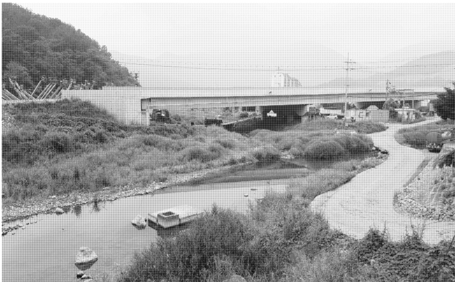
진해구 웅동지역 대장·소사천 생태하천복원사업 현장
